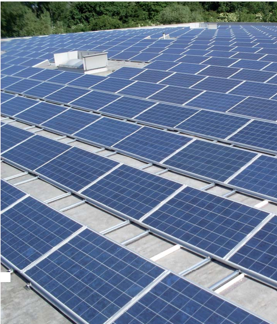
EasyPanels in Reih' und Glied – in Windeseile montiert, aber vom Wind verschont!
